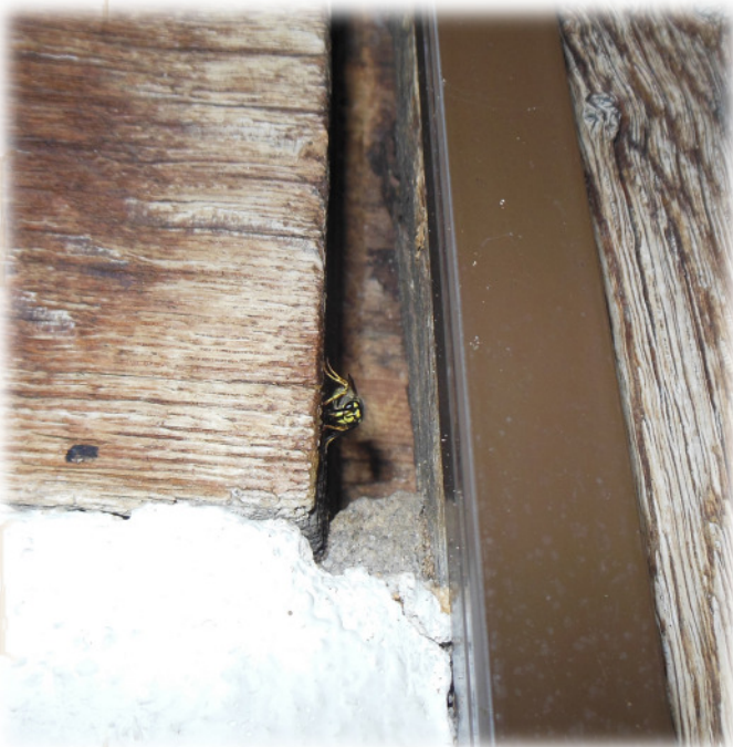
In der Zwischenwand eines Fachwerkhäuses.
